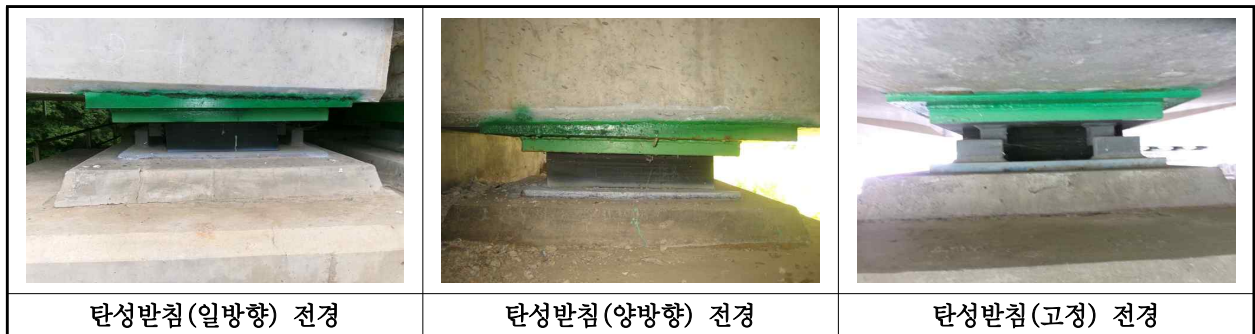
【사진 2.3.12】 교량받침 전경
