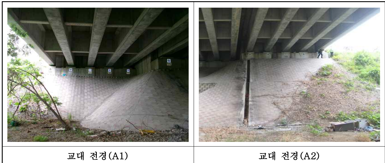
【사진 2.3.8】 교대 전경
