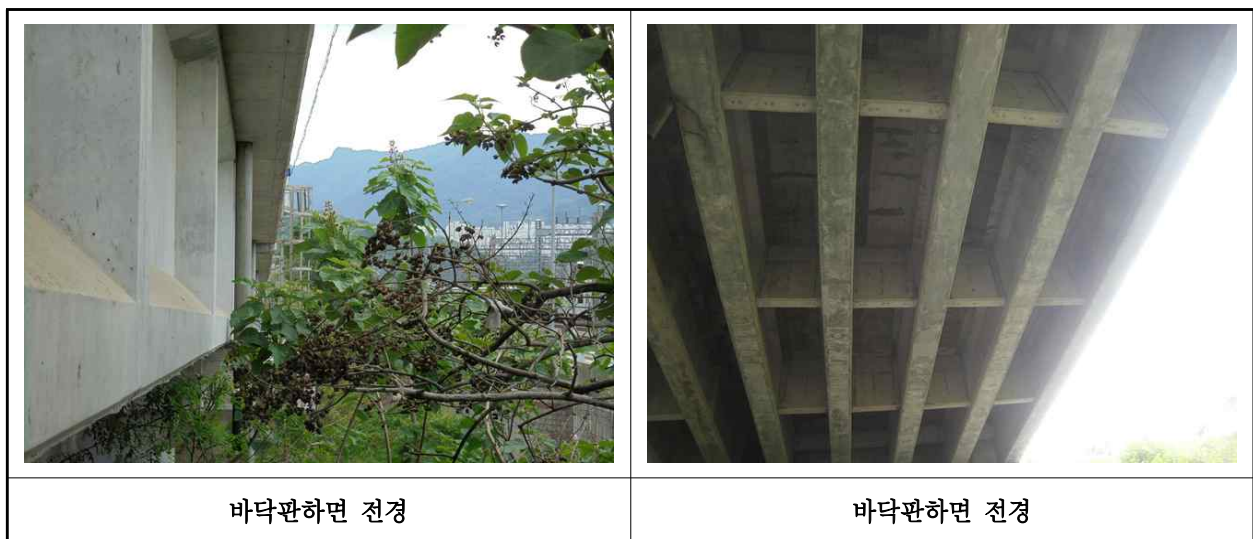
【사진 2.3.2】 바닥판하면 전경
