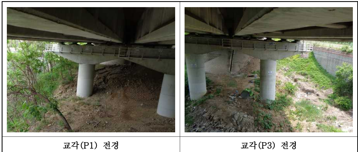
【사진 2.3.10】 교각 전경
