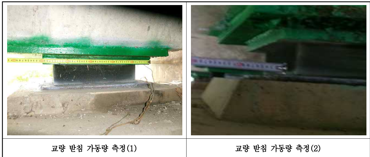
【사진 2.3.15】 교량받침 이동량 측정
