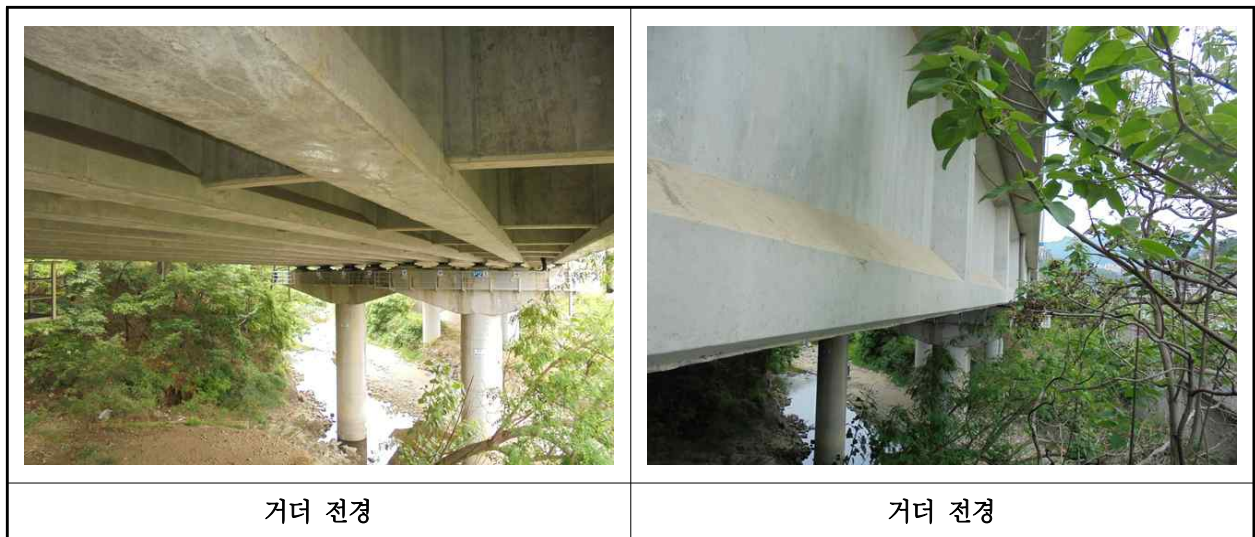
【사진 2.3.4】 거더 전경
