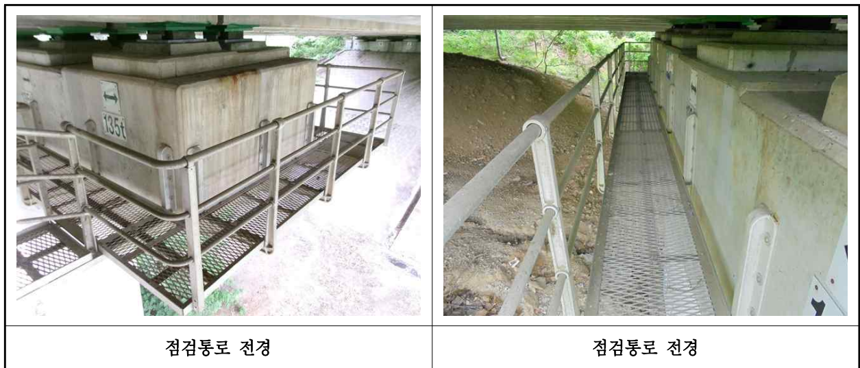
【사진 2.3.25】 교량 점검시설 전경
