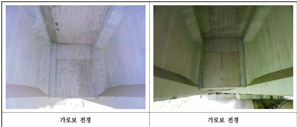
【사진 2.3.6】 가로보 전경
