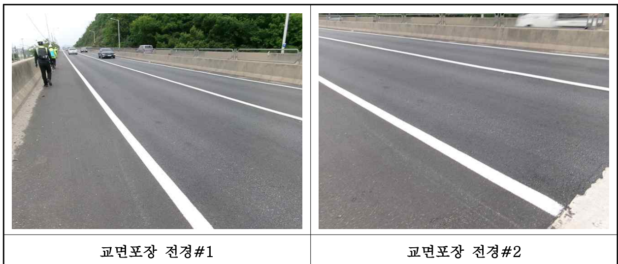
【사진 2.3.19】 교면포장 전경
