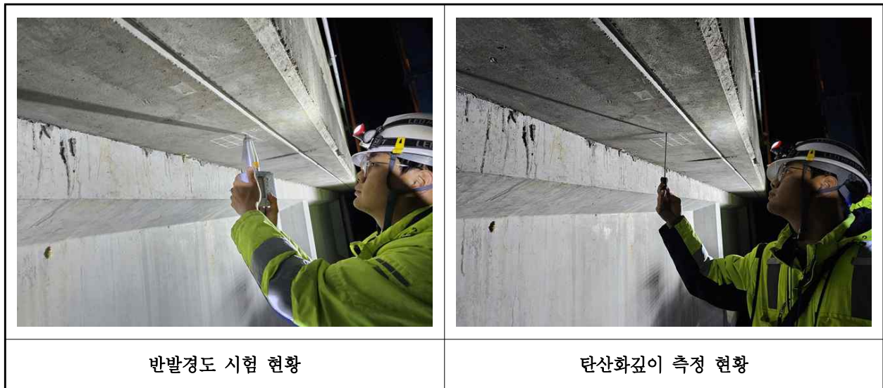
【사진 2.4.1】 콘크리트 내구성조사 현황
