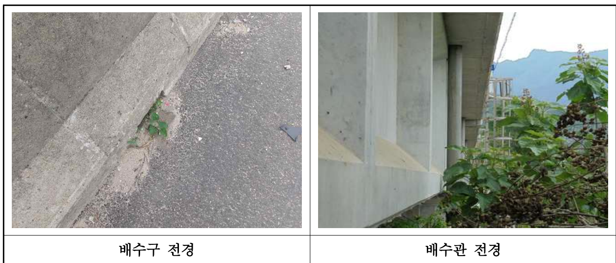
【사진 2.3.21】 배수시설 전경
